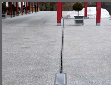
Bodenbelag aus Gussasphalt gemischt mit hellem Kies (abschliessend abgeschliffen) der Sonnenterrasse.
