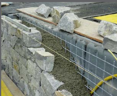
Die Natursteinblende beim neuen Seminargebäude war für die GaLaBauer eine besondere Herausforderung.
